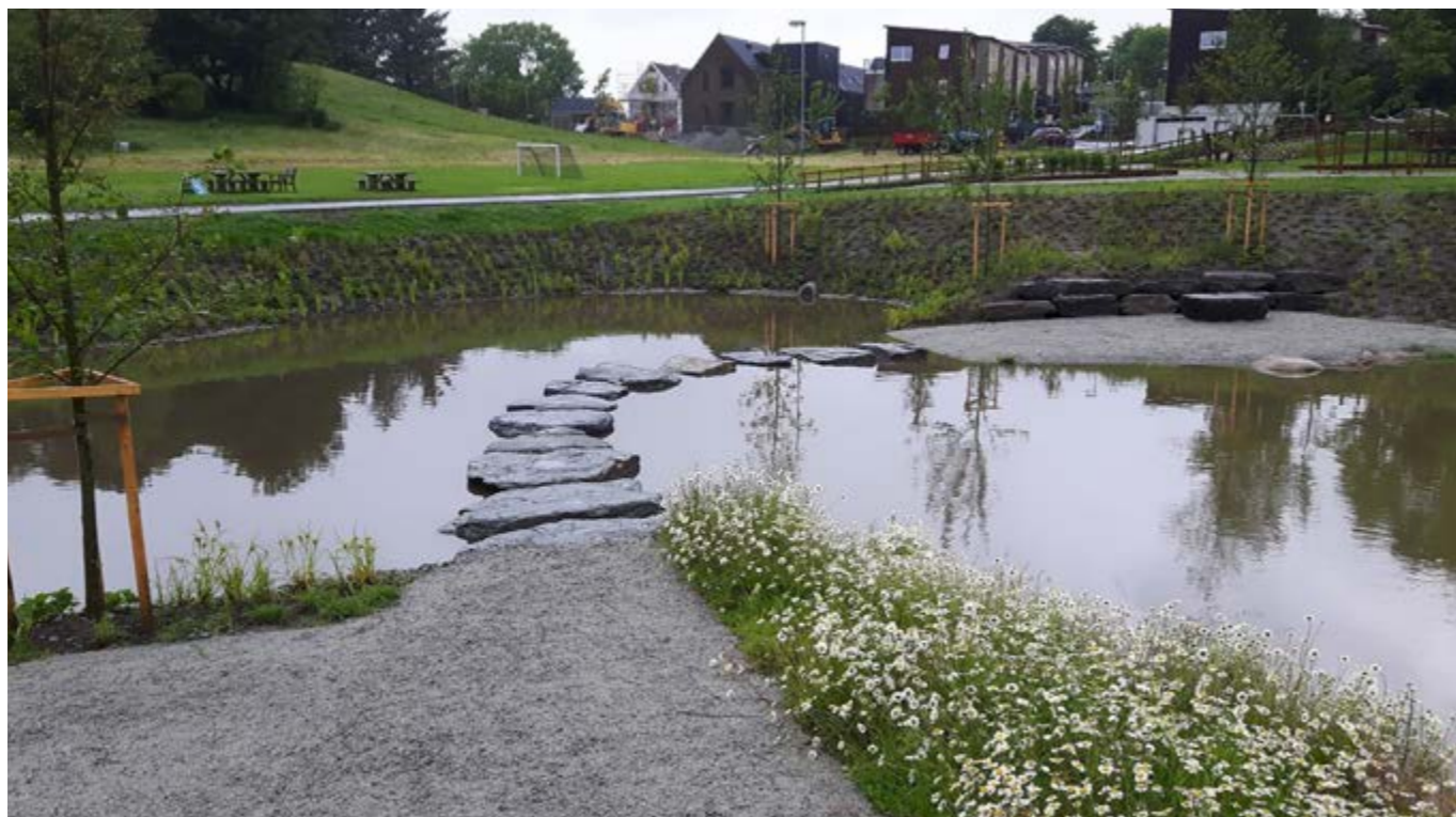
Vannspeil for overvannshåndtering. Et godt eksempel fra Emmaus i Stavanger. Her har et sentralt område med mye fuktig jord, som sjelden ble brukt, blitt til et flott, nytt friareal hvor regnvann fra nærområdet fanges opp.
