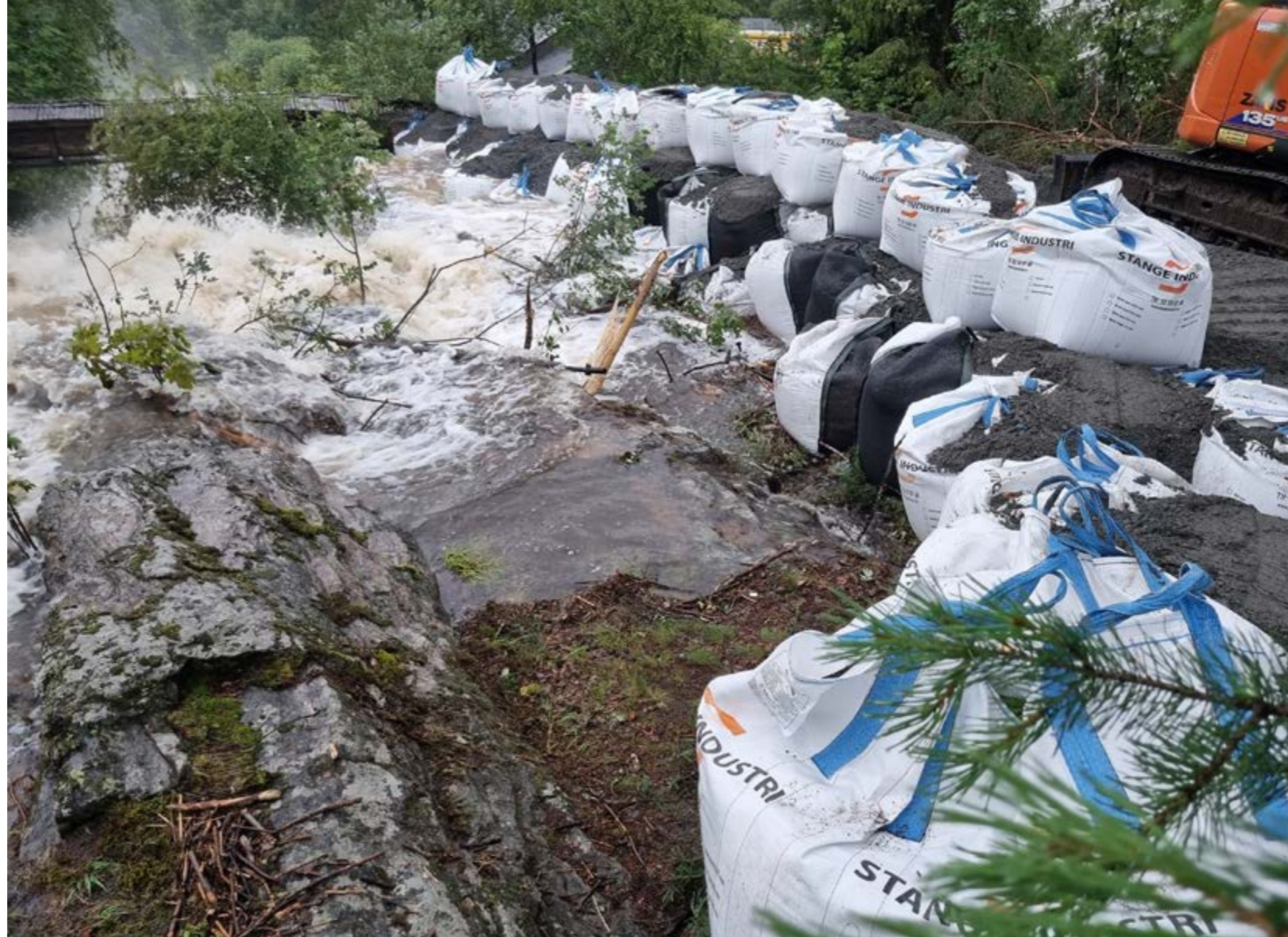
FOTO: PER EGGE Da Fallselva steg og begynte å komme over bergnabben mot boligfeltet, ble det laget et flomvern med over 120 storsekker med grus. Vannet steg nesten til toppen av flomvernet da ytterligere vannmengde ble sluppet gjennom demningslukene.
